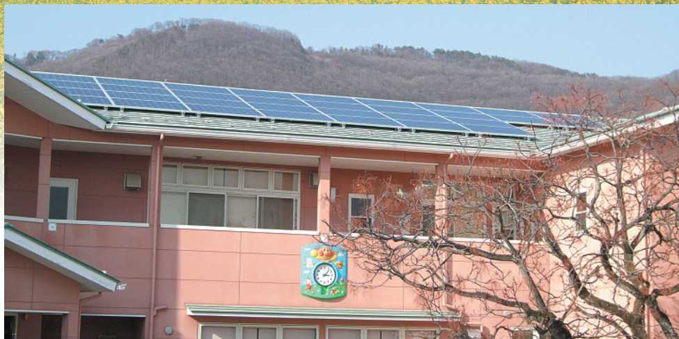
▲屋根に設置された太陽電池
